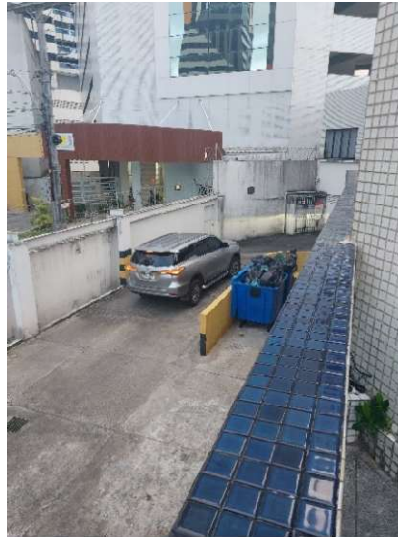
Rampa de acesso G3
