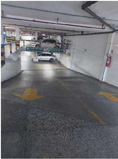
Rampa de acesso G2
